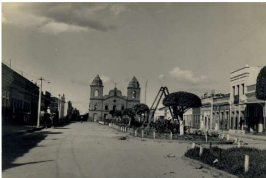
Obra feita no centro de Vitória, na Zona da Mata, possivelmente na década de 30. Crédito: Apeje/Divulgação
